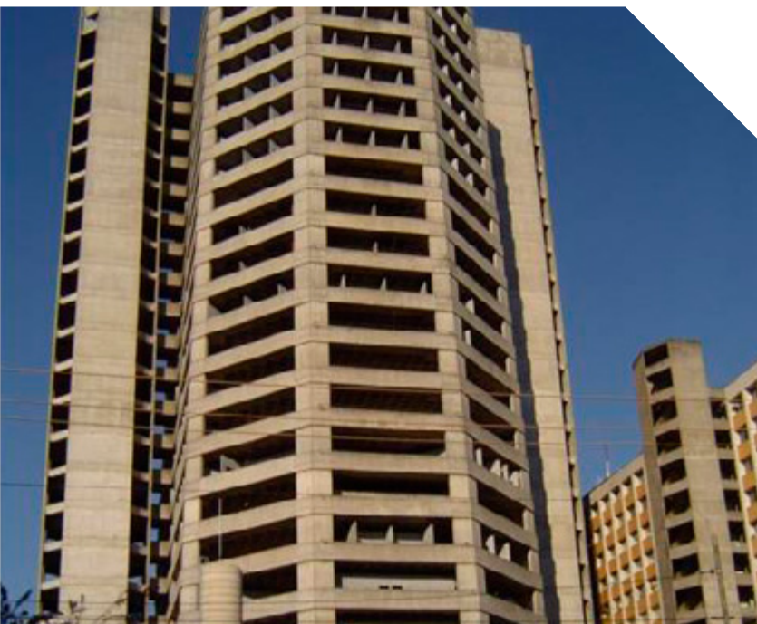
FACHADA DO PRÉDIO DO ICESP DURANTE SUA CONSTRUÇÃO EM 2004
