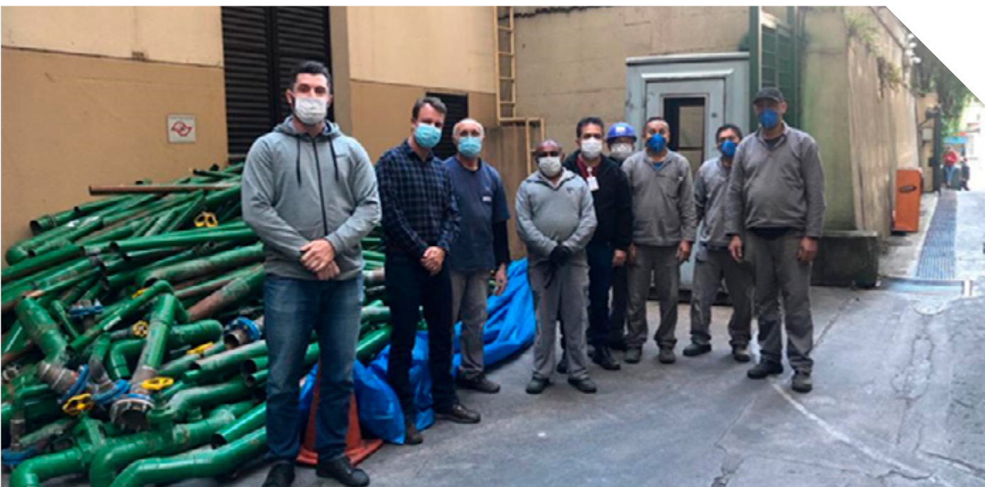
SUBSTITUIÇÃO DAS TUBULAÇÕES DE COBRE POR TUBOS DE POLIPROPILENO COPOLÍMERO RANDOM (PPR)
